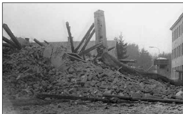
Město Libavá, demolice budovy (bývalá kasárna PTP) poblíž školy. Foto Jindřich Machala.
