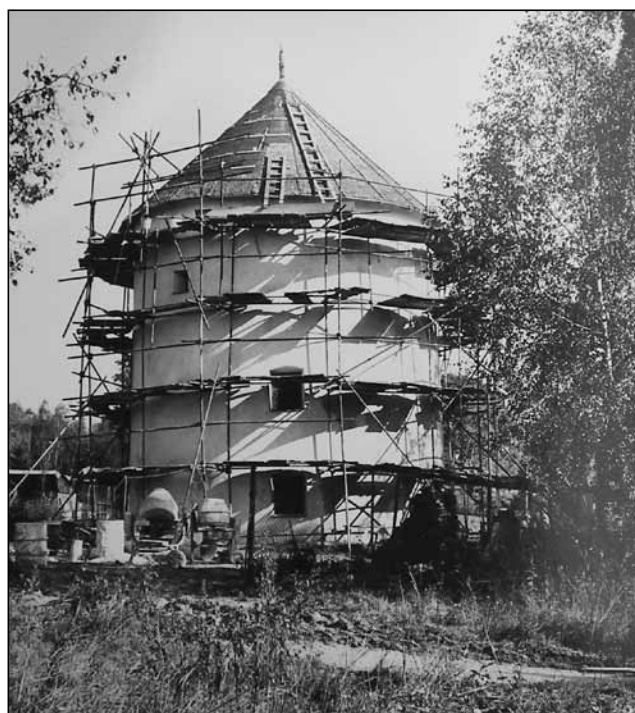
Oprava větrného mlýna ve Měste Libavé v roce 1996. Mlýn je zapsán v seznamu nemovitých památek. Foto Jindřich Machala.
