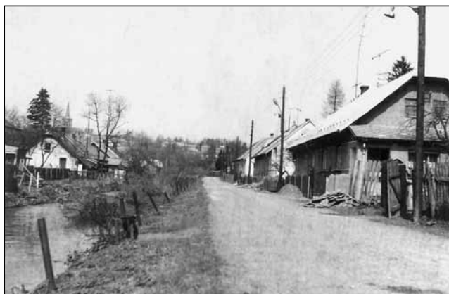
Město Libavá v roce 1978 – úprava komunikace a toku Libavského potoka. Foto Jindřich Machala.
