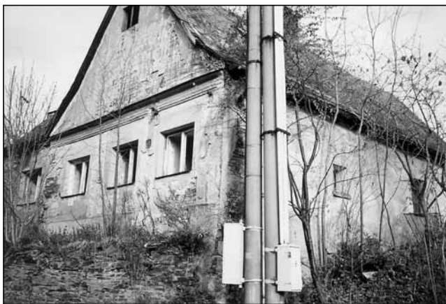
Město Libavá, typické stavení. Zbouráno v 90. letech 20. století. Foto Jindřich Machala.
