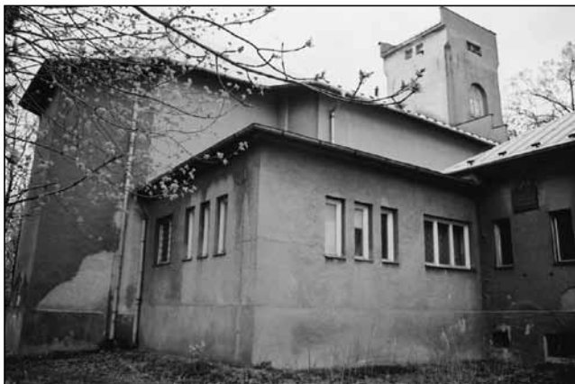
Bývalý farní kostel sv. Františka Serafínského ve Slavkově z roku 1763, nyní kulturní dům. Věž byla snesena, namísto sakristie byl zřízen bar a v presbytáři jeviště. Foto Jana Krejčová.
